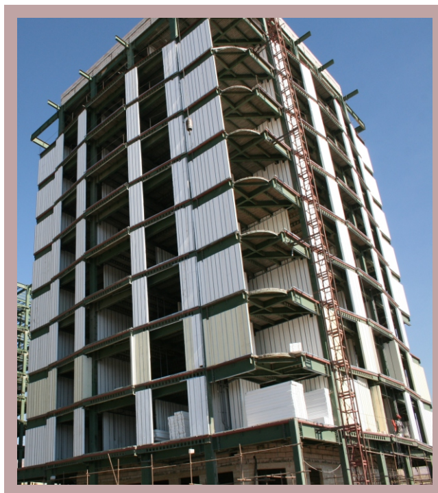
اجرای پارتیشن در اسکلت فلزی
