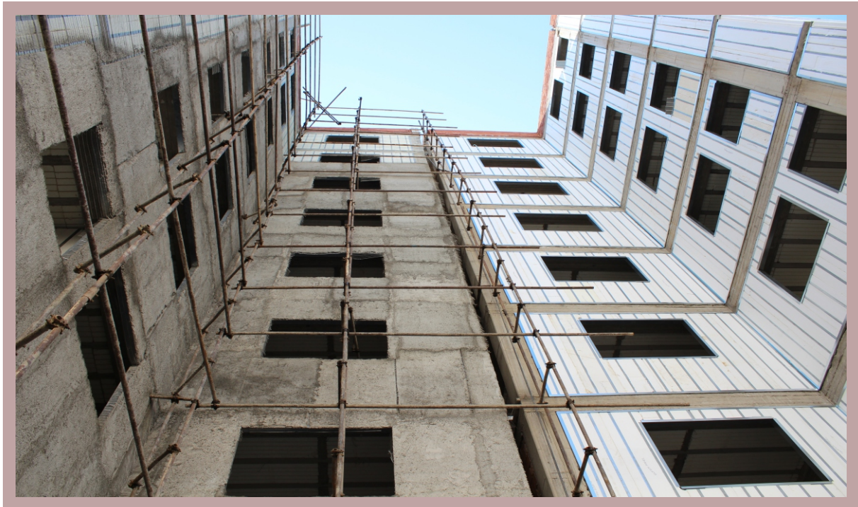
اجرای نازک کاری نما روی پارتیشن
