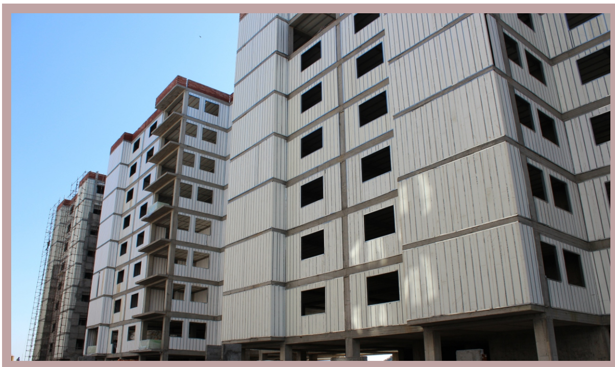
اجرای پارتیشن در اسکلت بتنی
