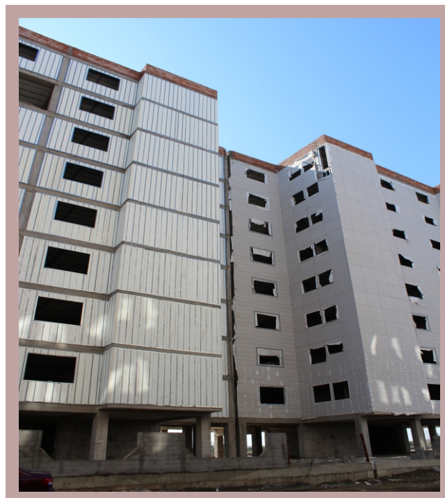
اجرای نازک کاری نما روی پارتیشن
