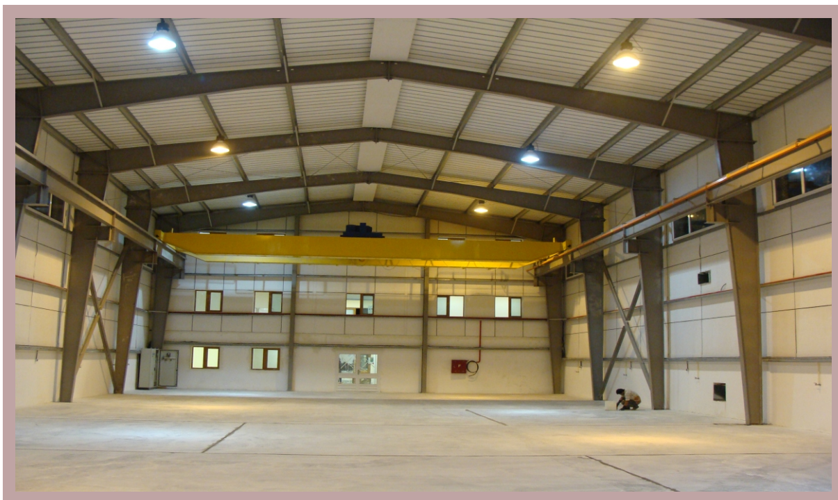
اجرای پارتیشن در دیوار سالنهای صنعتی و سقفهای سبک
