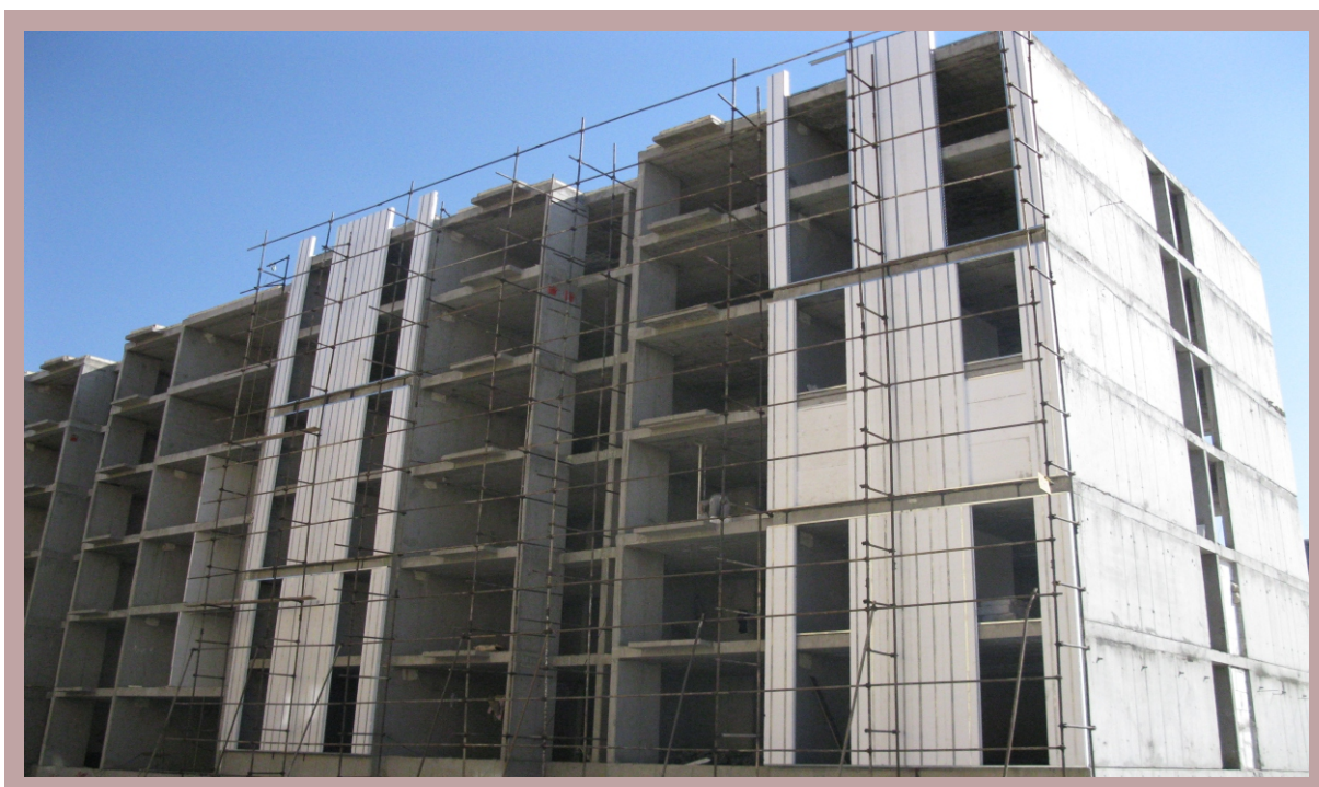
اجرای پارتیشن در اسکلت بتنی
