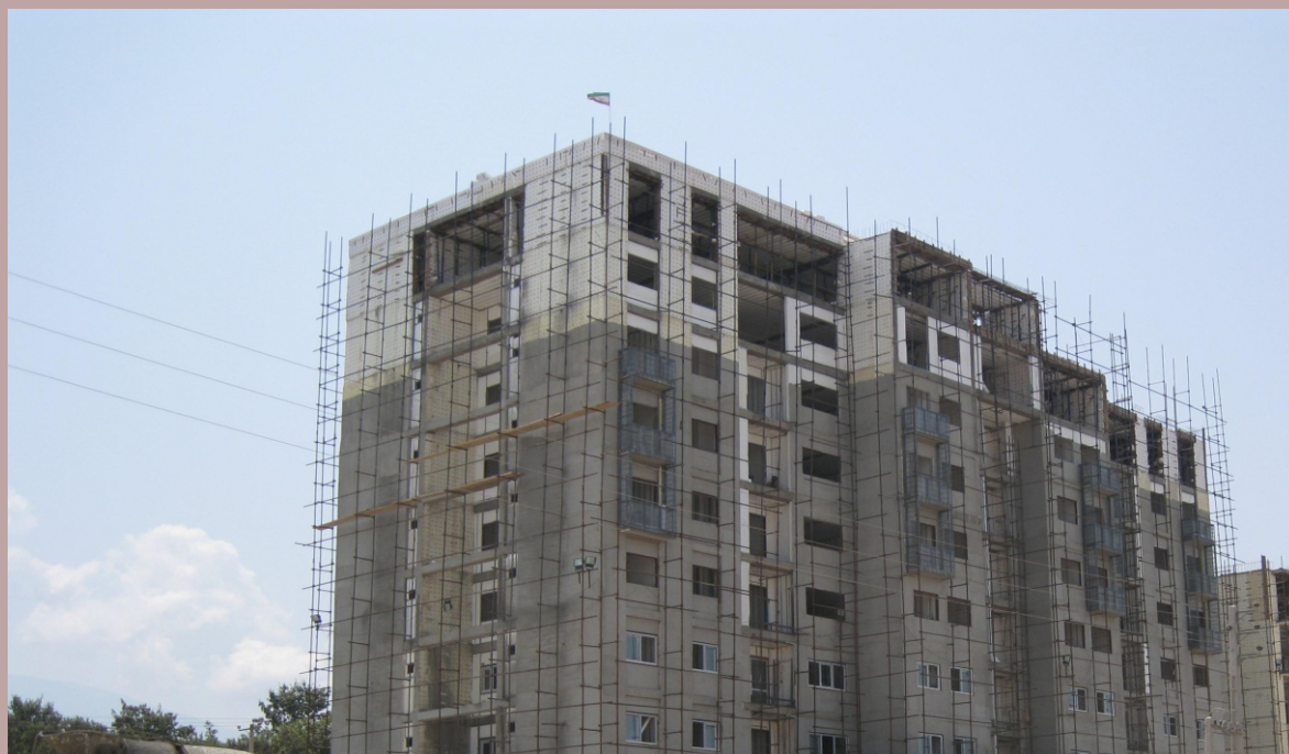
اجرای پارتیشن در سیستم ساختمانی سوپر پانل
