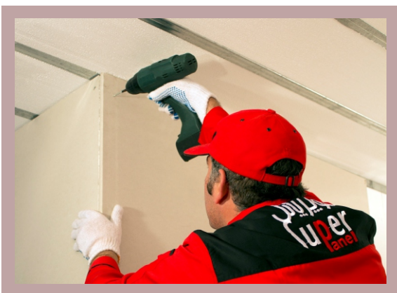
نازک کاری خشک روی دیوار
