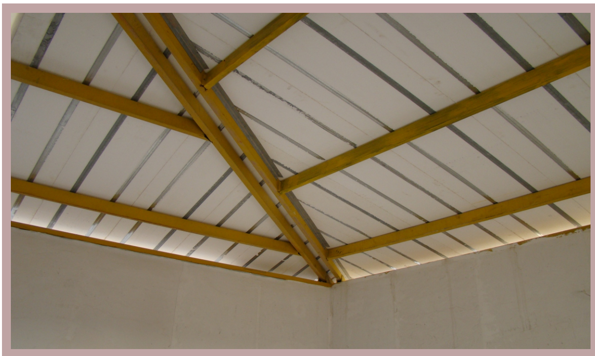
اجرای پارتیشن در سقفهای سبک
