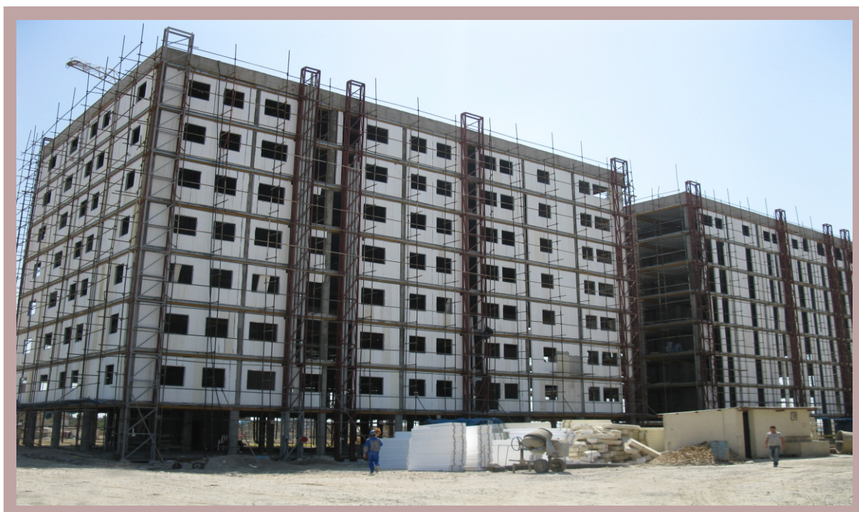
اجرای پارتیشن در اسکلت فلزی
