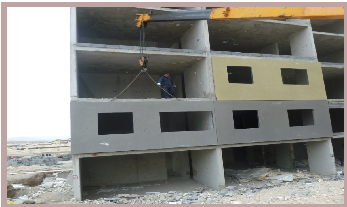
اجرای پارتیشن در نمای پیش ساخته
